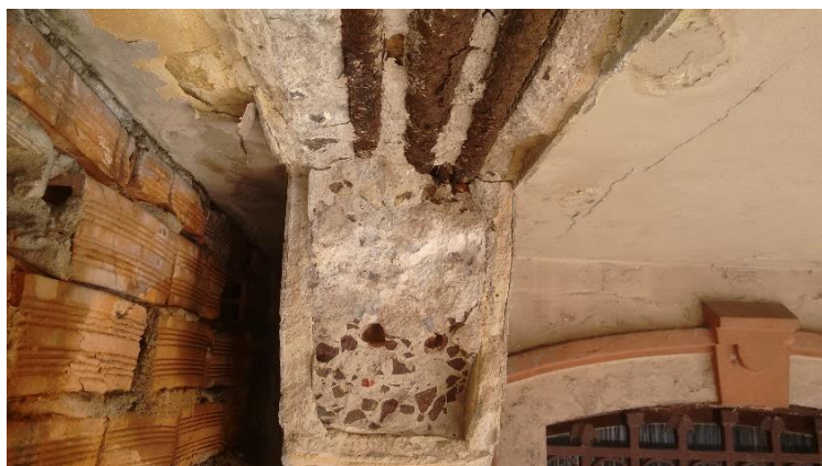
Figura 3 - Seção transversal da viga em balanço em concreto armado por perfis metálicos.
