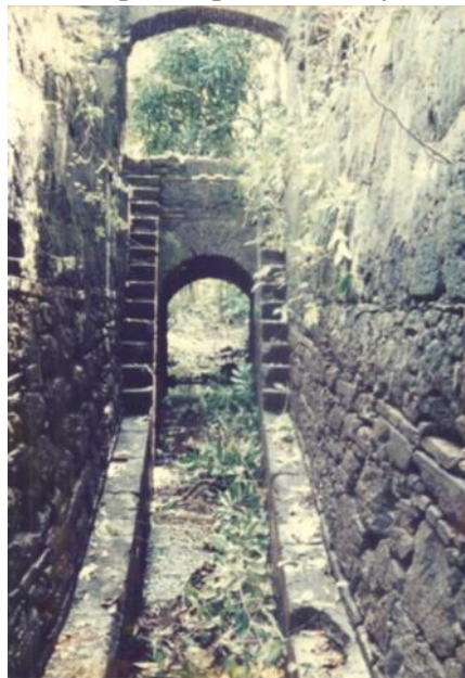
Figura 2 - Vista do interior de uma Calha, com paredes, abóbada, arco e escadas construídos em alvenaria de pedra aparelhada e tijolo maciço
